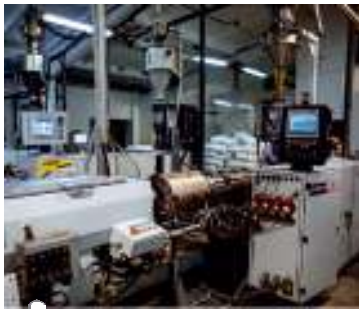
Цех по производству канализации
